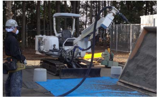
図6 斜面へのベントナイトの吹きつけ
